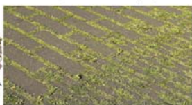
Exempel, platta för infiltration
